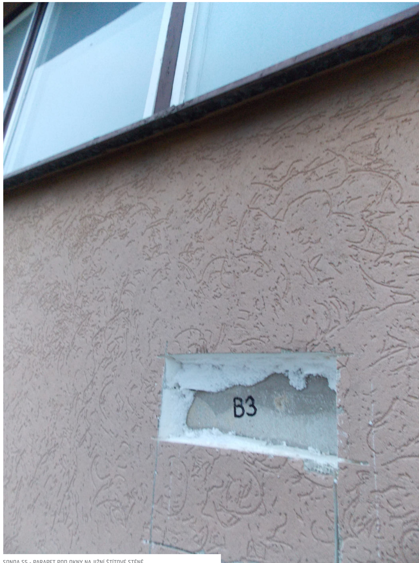
SONDA S5 - PARAPET POD OKNY NA JIŽNÍ ŠTÍTOVÉ STĚNĚ
