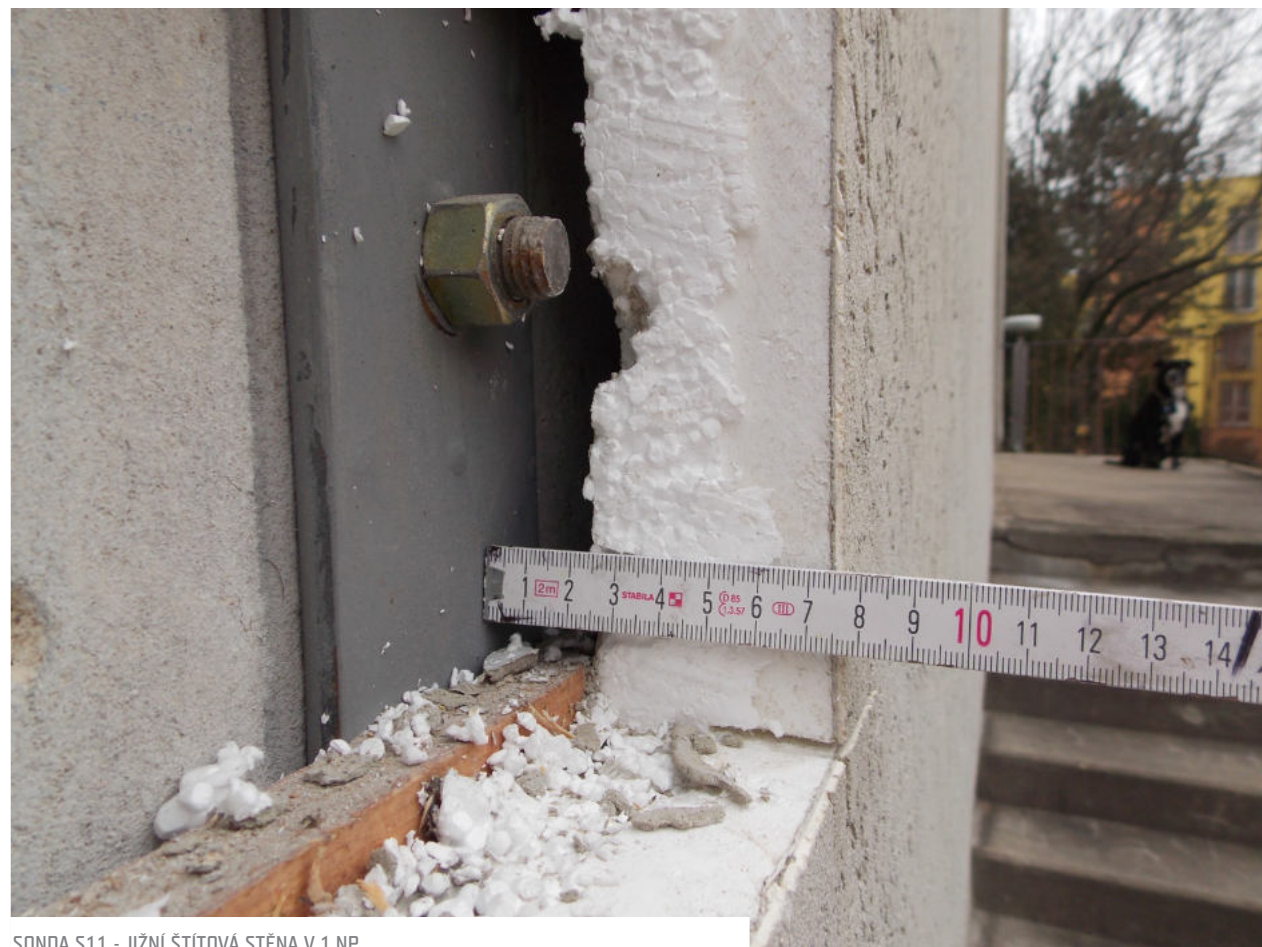
SONDA S11 - JIŽNÍ ŠTÍTOVÁ STĚNA V 1.NP
