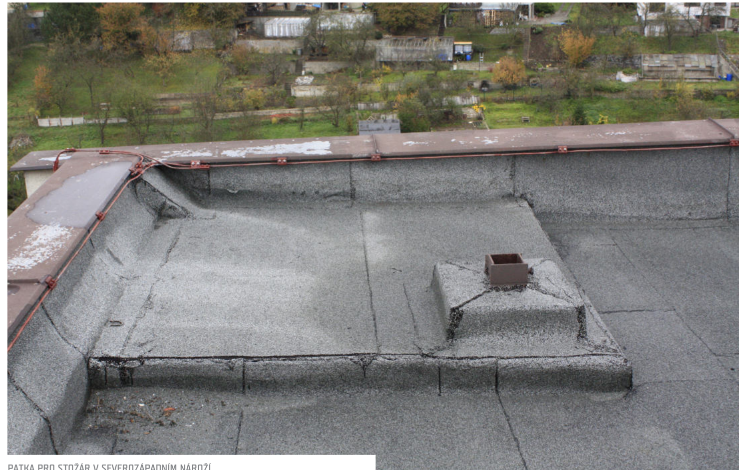
PATKA PRO STOŽÁR V SEVEROZÁPADNÍM NÁROŽÍ
