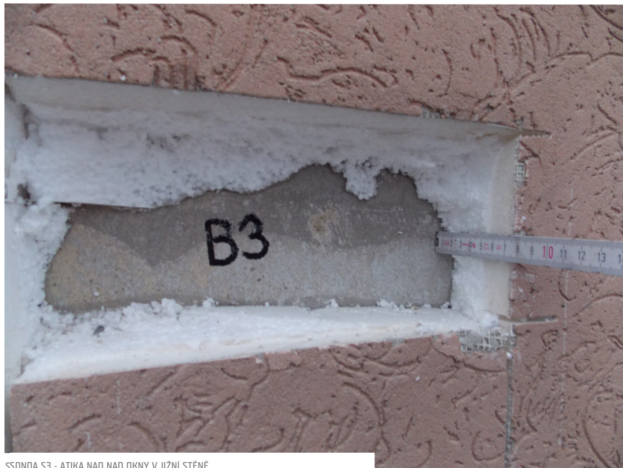
SSONDA S3 - ATIKA NAD NAD OKNY V JIŽNÍ STĚNĚ
